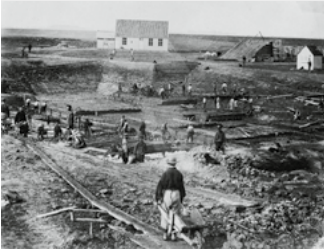
Arbeiders bezig met de aanleg van de spilsuis (1875)
